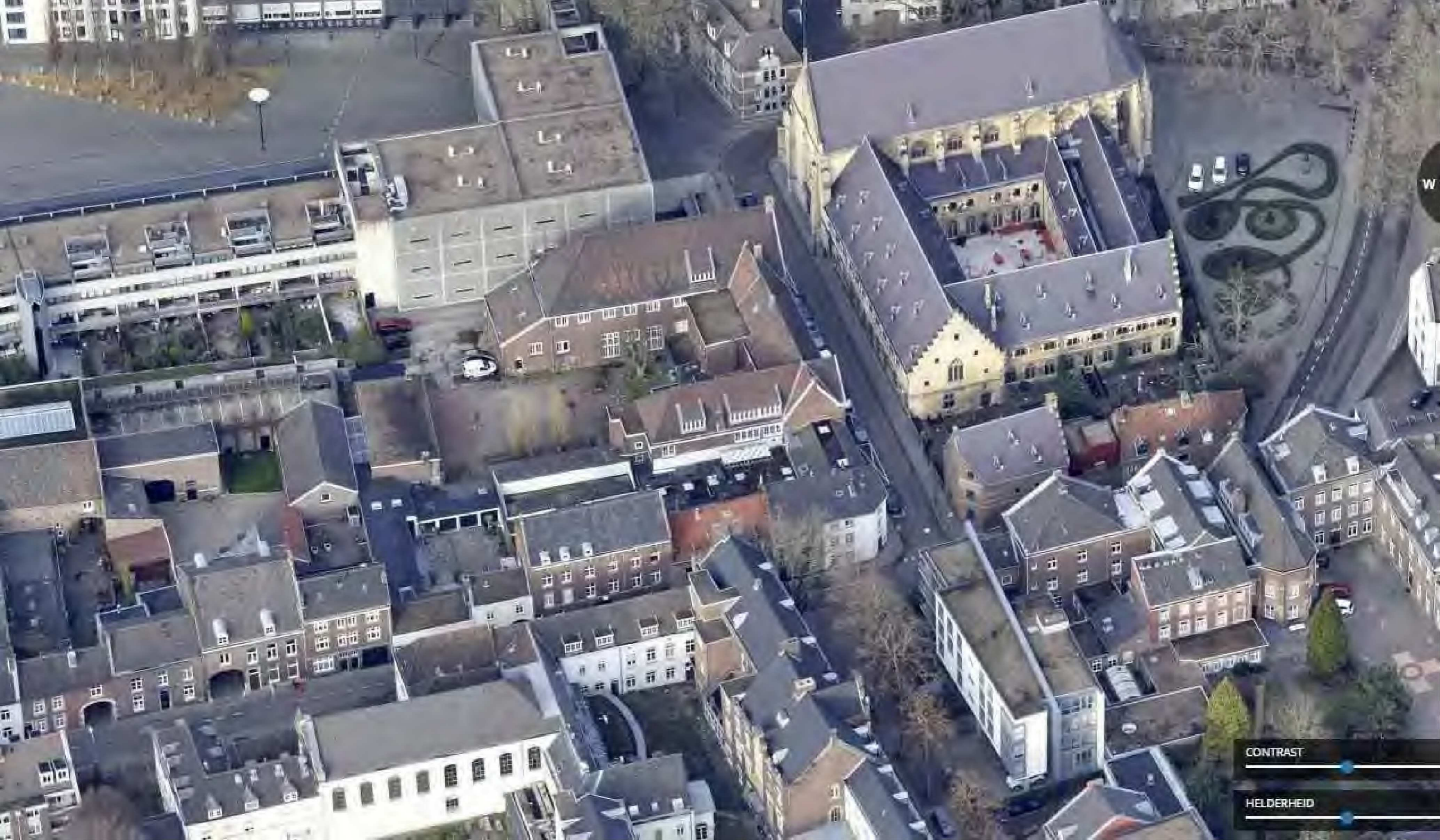
luchtfoto in noordelijke richting
